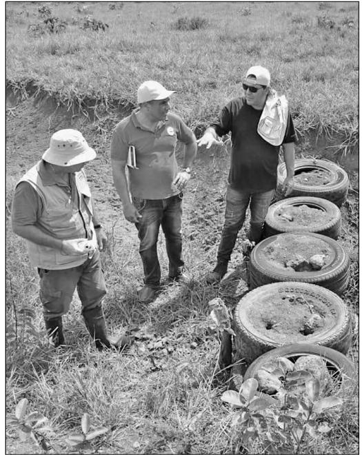
Colocación de muro de neumáticos para evitar frenar la erosión de una cárcava. Finca de la señora Hipólita Mitre. Cuenca del río Parita, provincia de Herrera.
