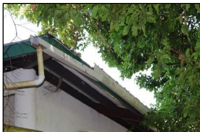
Figura 22. Canal averiado producto de malas prácticas de mantenimiento y limpieza.
