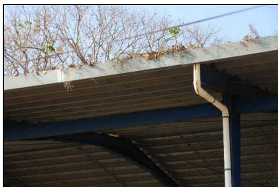
Figura 22. Canal averiado producto de malas prácticas de mantenimiento y limpieza.
