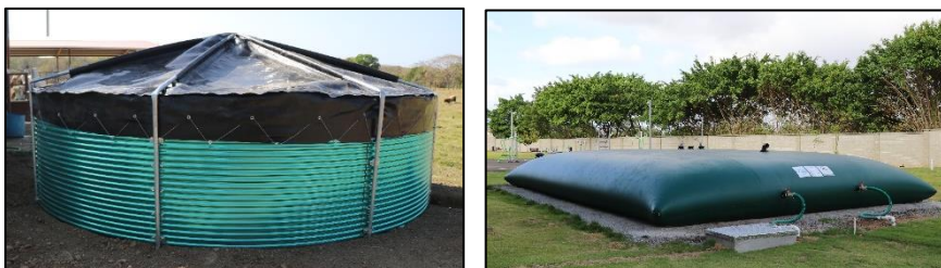
Figura 4. Tanque australiano para almacenamiento de agua (izq.). Tanque flexible para almacenamiento de agua (der.).
