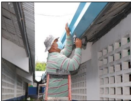
Figura 1. Instalación de canales y tubos de bajada en el IPT de Monte Lirio.
