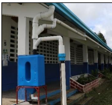
Figura 1. Instalación de canales y tubos de bajada en el IPT de Monte Lirio.
