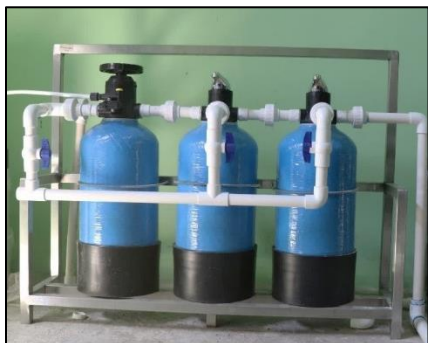
Figura 10. Filtro de grava, arenas sílicas y carbón activado.
