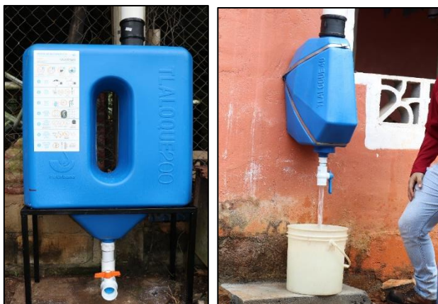
Figura 2. Separador de primeras lluvias con capacidad de 200 L (izq.) y 40 L (der.).
