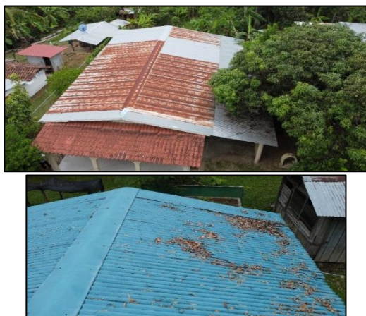
Figura 18. Ejemplos de techos sucios y rodeados por árboles antes de la instalación.
