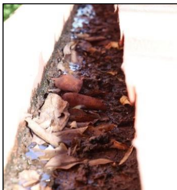
Figura 21. Canales con alto contenido de hojas y otros materiales orgánicos por falta de mantenimiento (izq.), Mantenimiento y limpieza de canales (der.)
