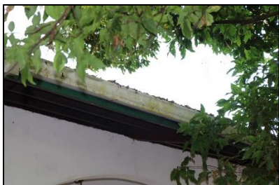
Figura 22. Canal averiado producto de malas prácticas de mantenimiento y limpieza.
